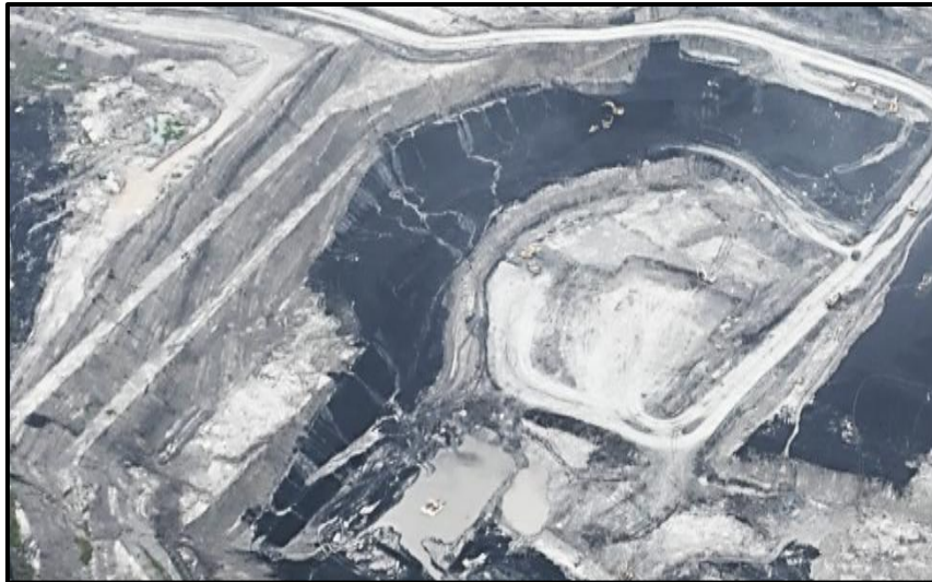
Gambar 1. Kondisi Seam C pada Area Bottom pit Jatiluhur
